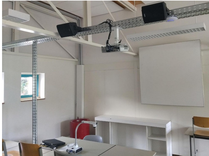
Abbildung 5: Die Ausstattung im Raum 113 (Shedtrakt) im Überblick. Unter dem rechten Lautsprecher ist der WLAN-Access-Point zu erkennen.
